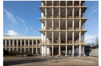
↑ Rückbau bei Erhaltung der gesamten Stahlbetonstruktur
